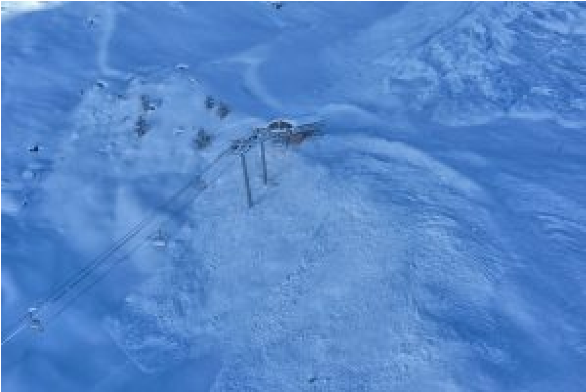
Figure 3 : gare d'arrivée du TSD l'Arcelle vue depuis hélicoptère après l'avalanche du 25 novembre 2016. Source : Service des pistes de Val Cenis.
