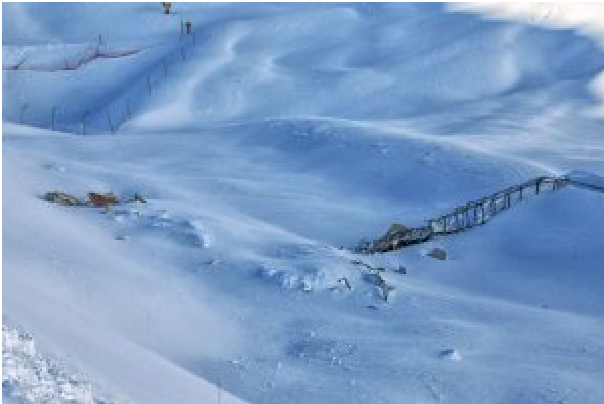
Figure 5 : tapis du Grand Yéti endommagé après l'avalanche du 16 janvier 2017. Source : Service des pistes de Cauterets.
