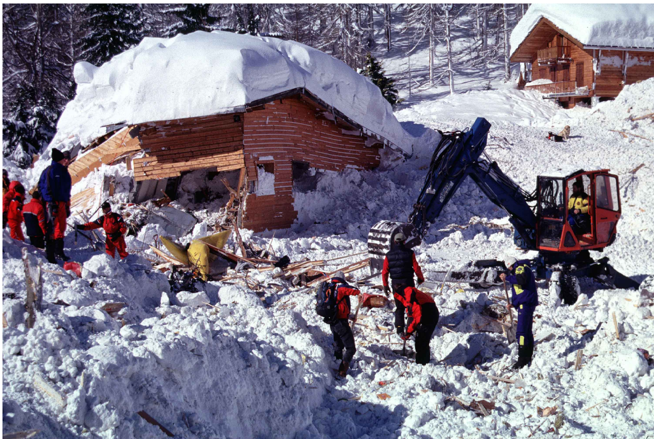
Figure 3. Les opérations de secours dans le hameau de Montroc (Chamonix, France) après qu'une avalanche a détruit vingt chalets et tué 12 occupants le 9 février 1999.
