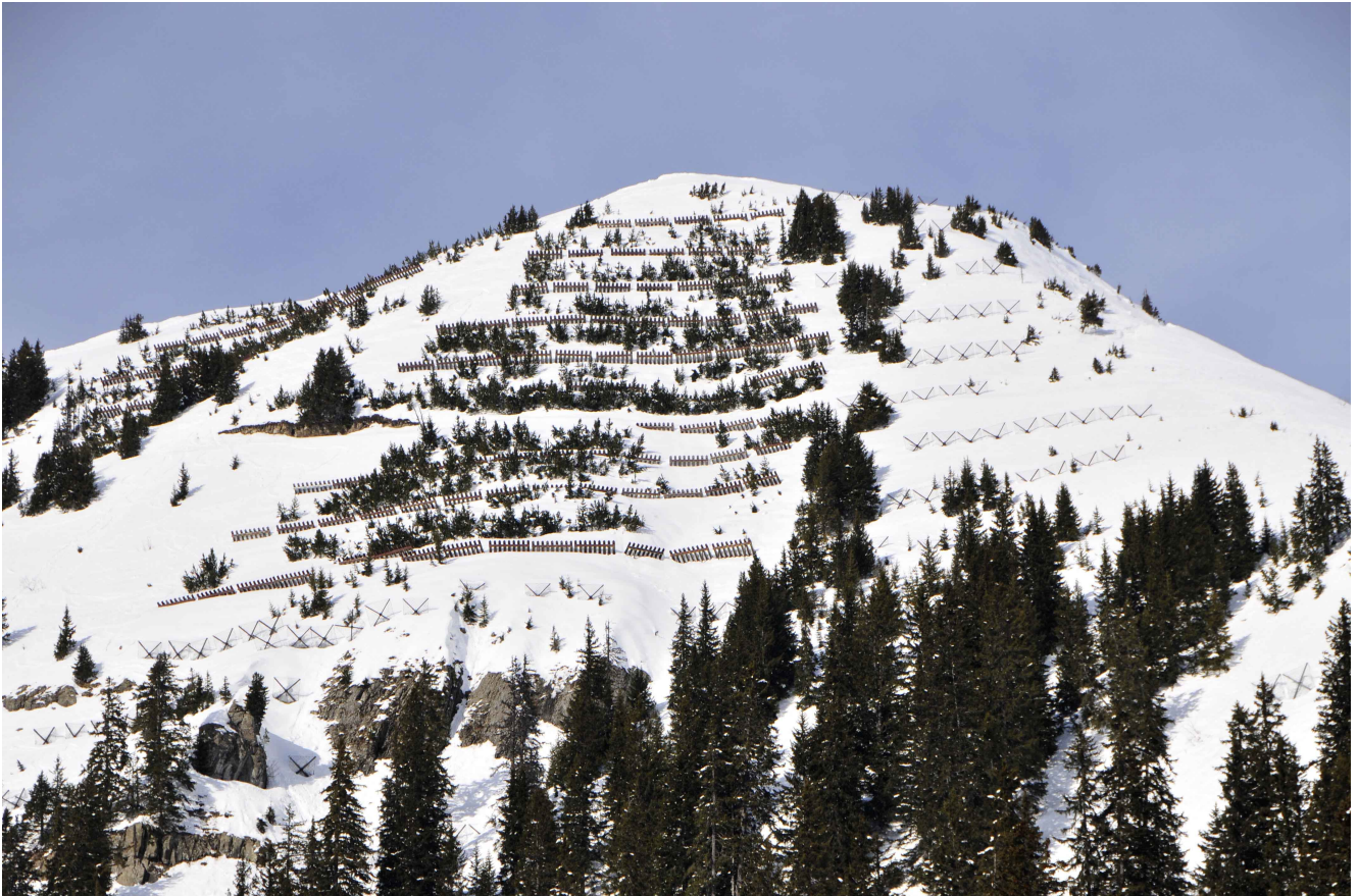
Figure 2. Mélanges de techniques de protection active dans la station de ski de Flaine (Haute-Savoie, France): partout où la couverture forestière n'est pas suffisante à empêcher la formation d'avalanche, des râteliers (au milieu) et des croisillons métalliques appelés Vela (à droite) ont été placés dans les espaces entre les arbres.
