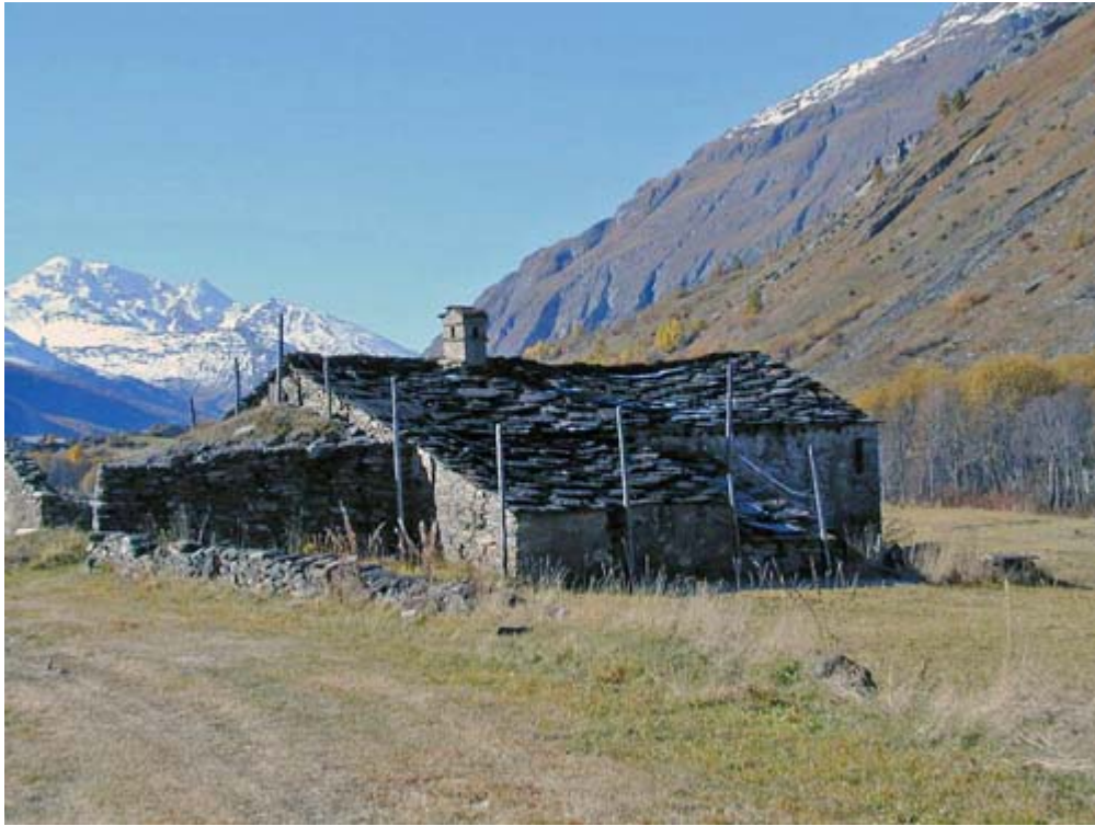
Etrave protégeant une bergerie (Bessans, Savoie).
