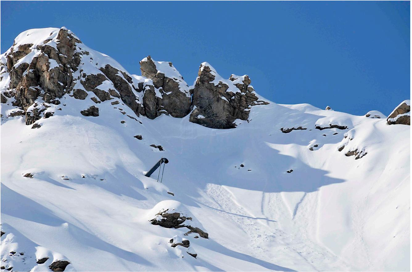
**Figure 3** : tube Gazex émergeant du manteau neigeux. La détonation du mélange propane-oxygène est réalisée dans une chambre sous terre, puis se propage dans le tube, qui dirige l'onde de choc vers le manteau neigeux.
