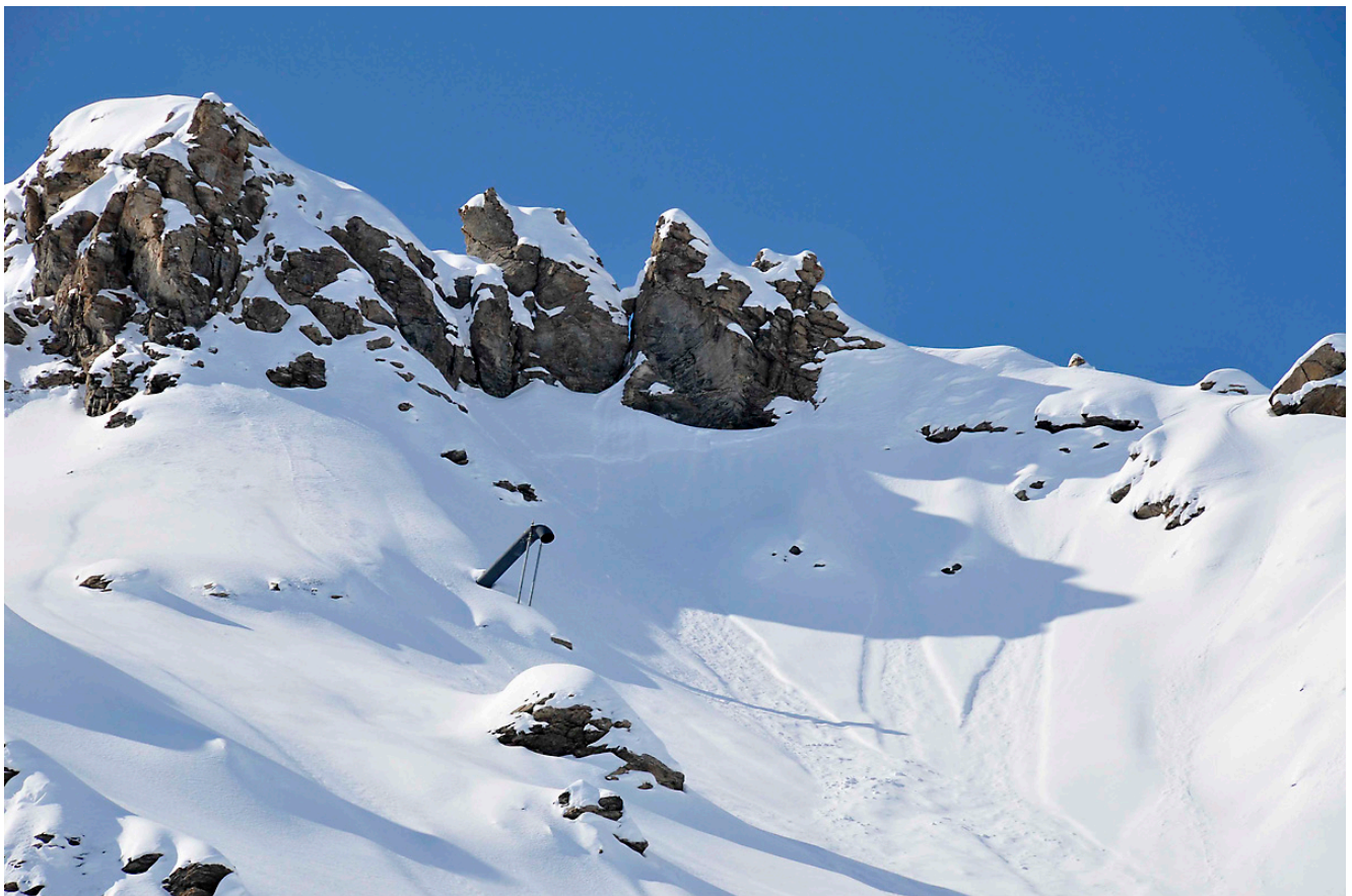
Figure 3 : tube Gazex émergeant du manteau neigeux. La détonation du mélange propane-oxygène est réalisée dans une chambre sous terre, puis se propage dans le tube, qui dirige l'onde de choc vers le manteau neigeux. Les études in situ, comme celles de Juerg Schweizer (SLF), ont
