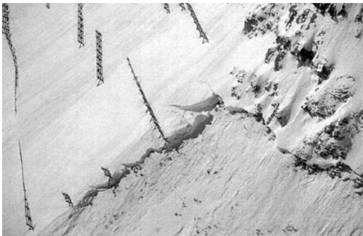
Lignes de claies abimées au-dessus de Zermatt (Valais). Source : SLF
