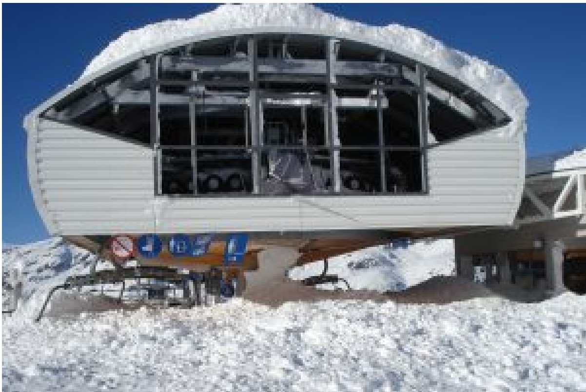
Figure 4 : dommage à la gare (endommagement des surfaces en plexiglas du tympan). Source : Service des pistes de Val
